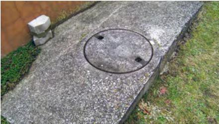
*Risse in der Betoneinfassung führen zu Undichtigkeiten*
