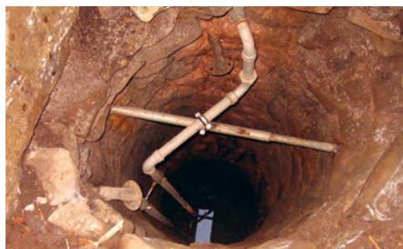
*Korrodierte Rohre, starke Eisenoxidausfällungen*
